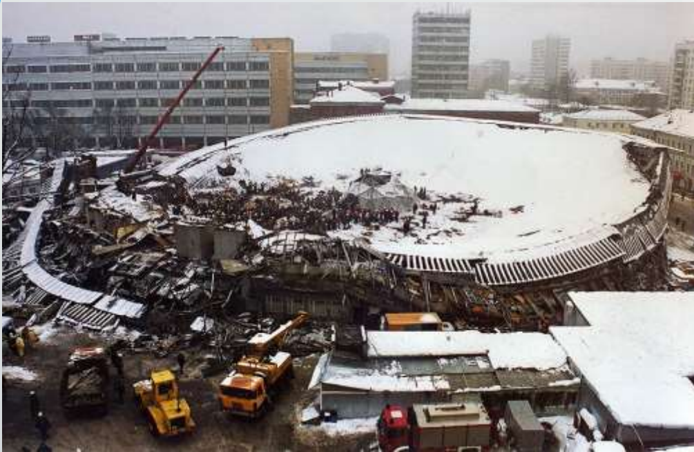
ОБРУШЕНИЕ БАСМАННОГО РЫНКА 23.02.2006
